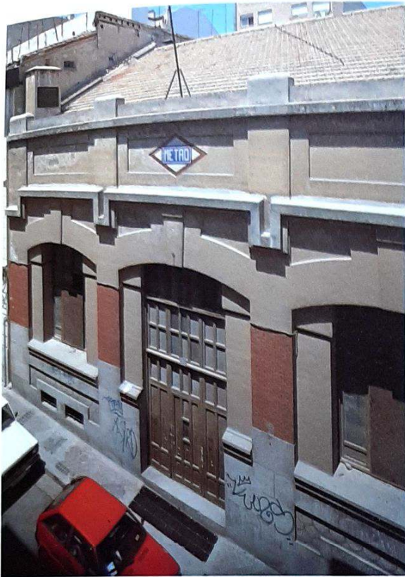
Subestación eléctrica de Quevedo en la actualidad.
