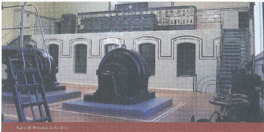
Nave de Motores de Pacífico
