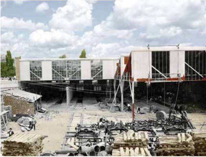
Construcción de las Cocheras de Cuatro Caminos, en 1919. Coloreada por los autores.
