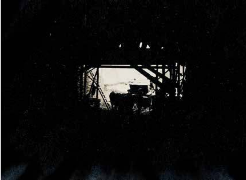
Postal de época. Túnel de salida a las Cocheras de Cuatro Caminos, 1918. Fondo autores.
