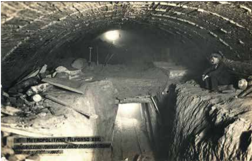
Vista del túnel en obras en el tramo Gran Vía-Tribunal. 8 de febrero de 1918. Fondo autores.
