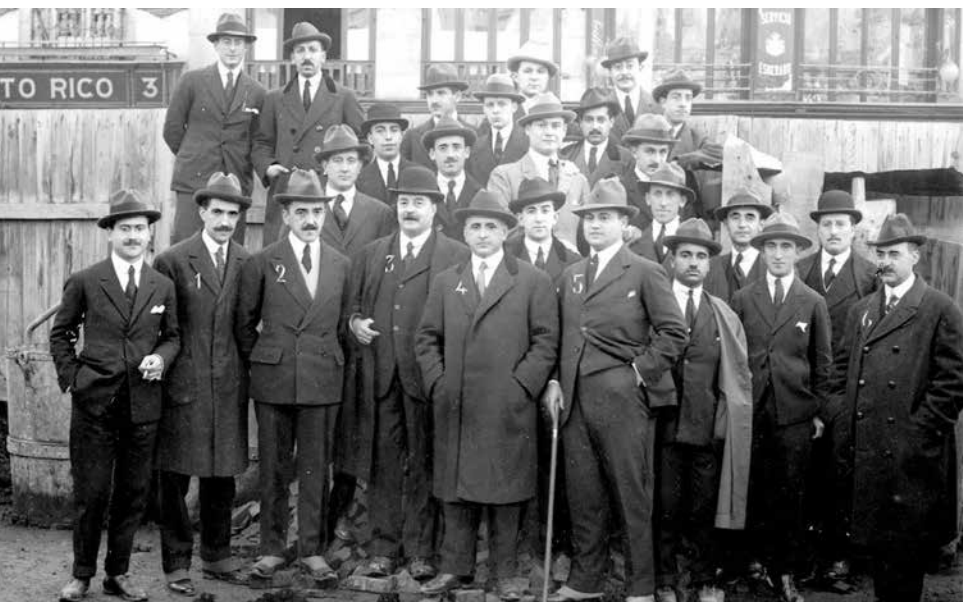
Visita a las obras del Metropolitano con Antonio Palacios y Miguel Otamendi, publicado por ABC , 4 de diciembre de 1918.
