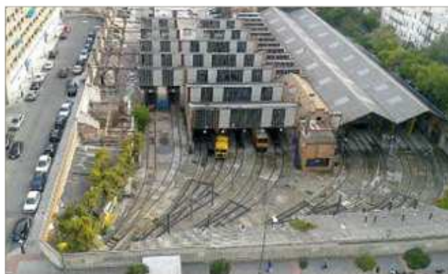
Foto aérea de las cocheras de Cuatro Caminos. Foto: Ramiro Linaza.
