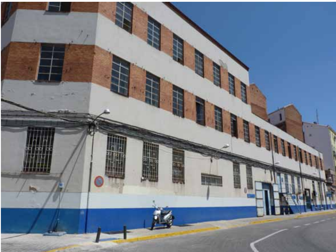
Fig5.10- Edificio de almacenes construido en 1933-1936 en la esquina de las calles Virgen de Nieve con Esquilache. Luis Manuel Marco
