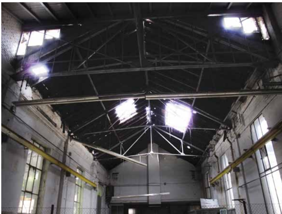
Figs.V.11- Interior de la Nave C (1919) donde sobreviven tres tramos de la variante de la cercha original. Esta nave debía albergar los talleres de oficios manuales como forja, carpintería o cerrajería. Álvaro Bonet López
