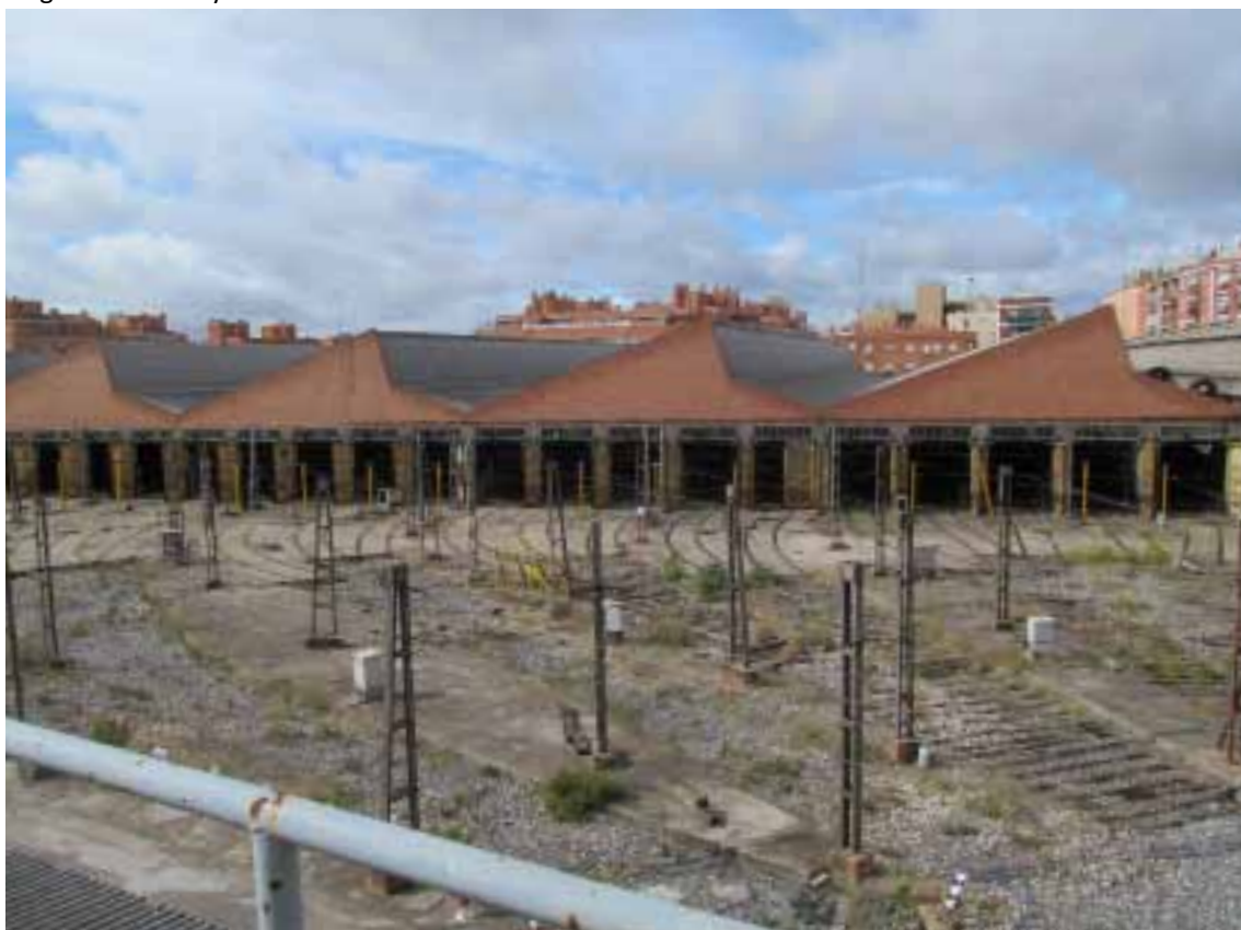
Figs.6.26 y 6.27- Cocheras de Metro de Madrid en Ventas (1924) y en Plaza de Castilla (1966). Las Cocheras de Cuatro Caminos fijaron un modelo en cuanto a la abundante iluminación de las naves, pero este sistema resultaba difícil de aplicar en parcelas con una orientación que no fuera norte-sur. Esta fue la razón del empleo de sistemas de cubierta en faldón quebrado, que dejaban una extensa banda de lucernario. Víctor Hugo Hernández y Álvaro Valdés
