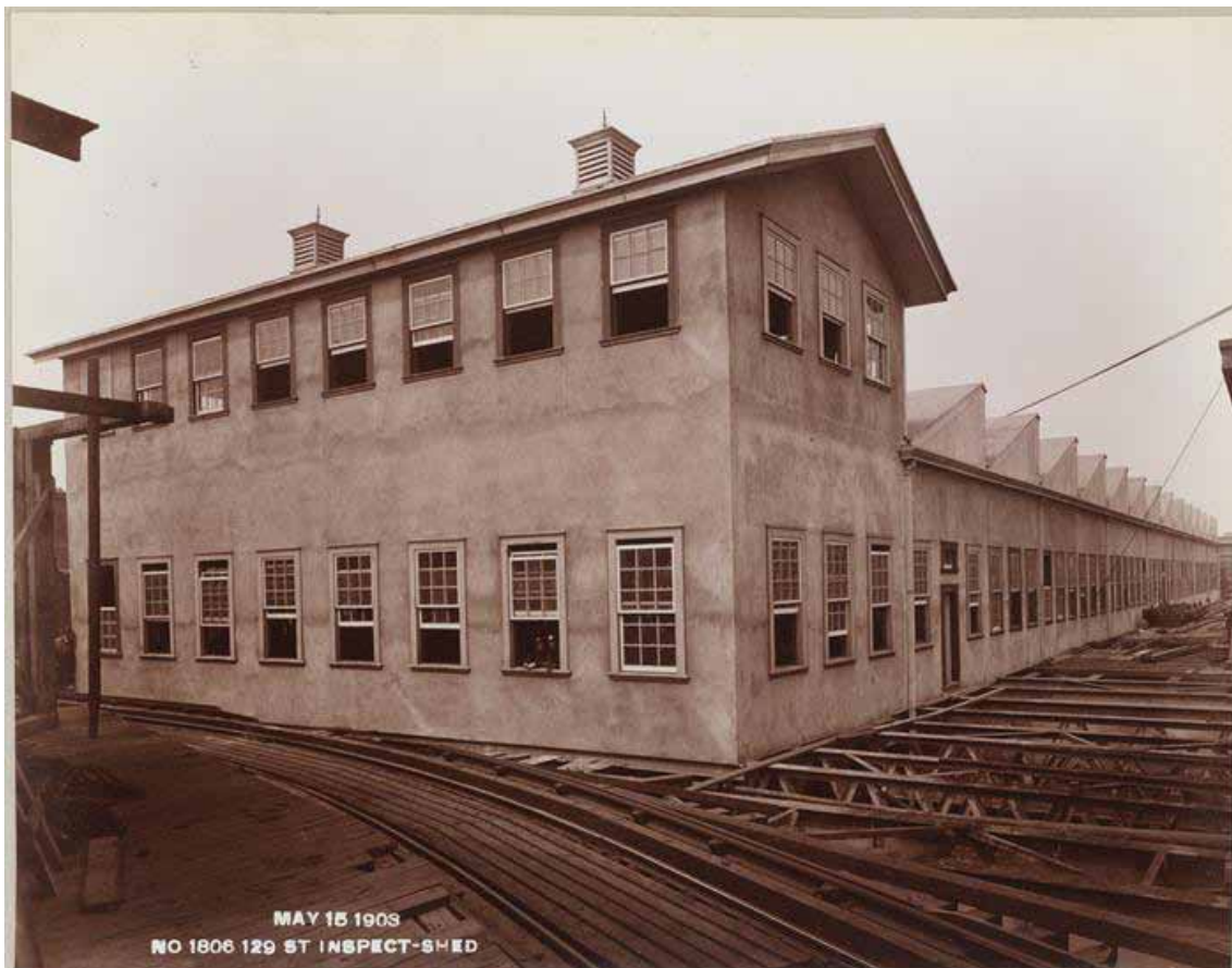
Figs. 6.14 y 6.15- La 129 Street Inspection Shed en construcción, 1908. Servía al Manhattan Railway y es el primer ejemplo del tipo norteamericano de cochera. Museum of the City of New York
