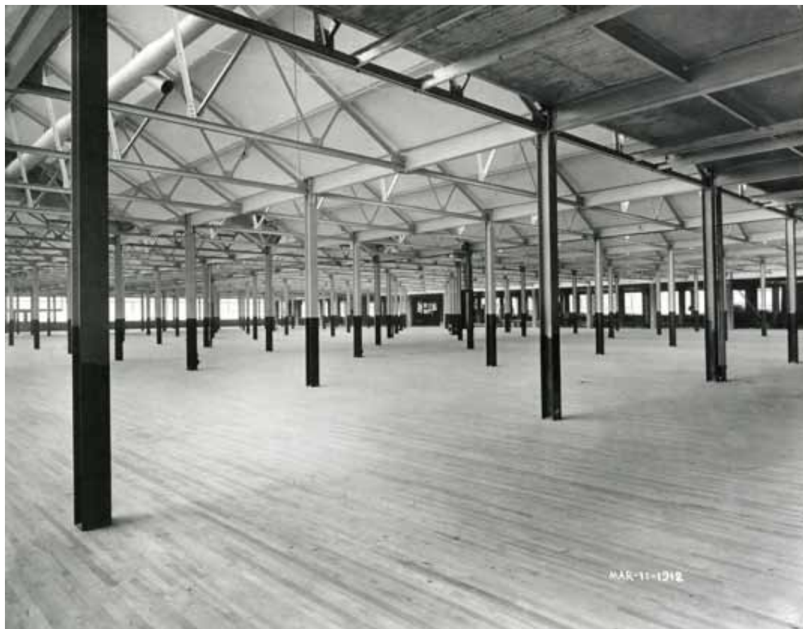
Figs. 6.8 y 6.9- Pierce Arrow Motor Car Works (1906) en Buffalo, Nueva York y Continental Motor Car Factory (1911) en Detroit, Michigan. Ambas diseñadas por Albert Kahn. Son dos de los primeros exponentes de lo que se dio en llamar la daylight factory , un modelo de planta industrial en que se priorizaba la iluminación a través de lucernarios en shed y amplios ventanales en los muros de cerramiento. Muestran la experimentación constructiva con materiales como el acero y el hormigón. A partir de la planta de Ford en River Rouge (1915) Kahn abandonará los esqueletos de hormigón para centrarse en las estructuras metálicas. Cyclopedia Of Architecture, Carpentry And Building (1912) y Albert Kahn Associates
