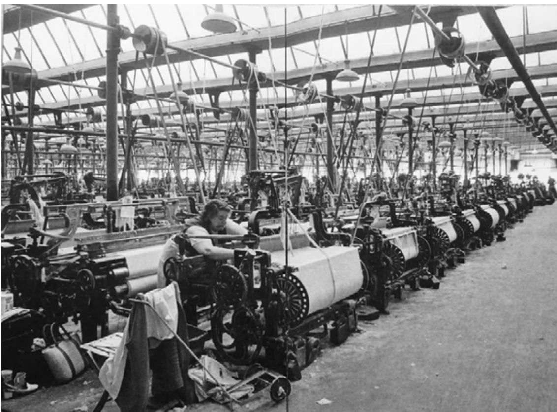
Figs. 6.4 y 6.5- Las naves en shed surgen vinculadas a las weaving sheds o hilanderías. Este sistema de cubierta se apoyaba en una retícula de pies derechos. La distancia entre apoyos no suponía ningún problema en las fábricas textiles, pero limitaba su adaptación a otros usos industriales. Barcroft Mills (1914-1920) y Horwich Works Paint Shop , Lancashire (1887). National Railway Museum y Daniel Meadows.
