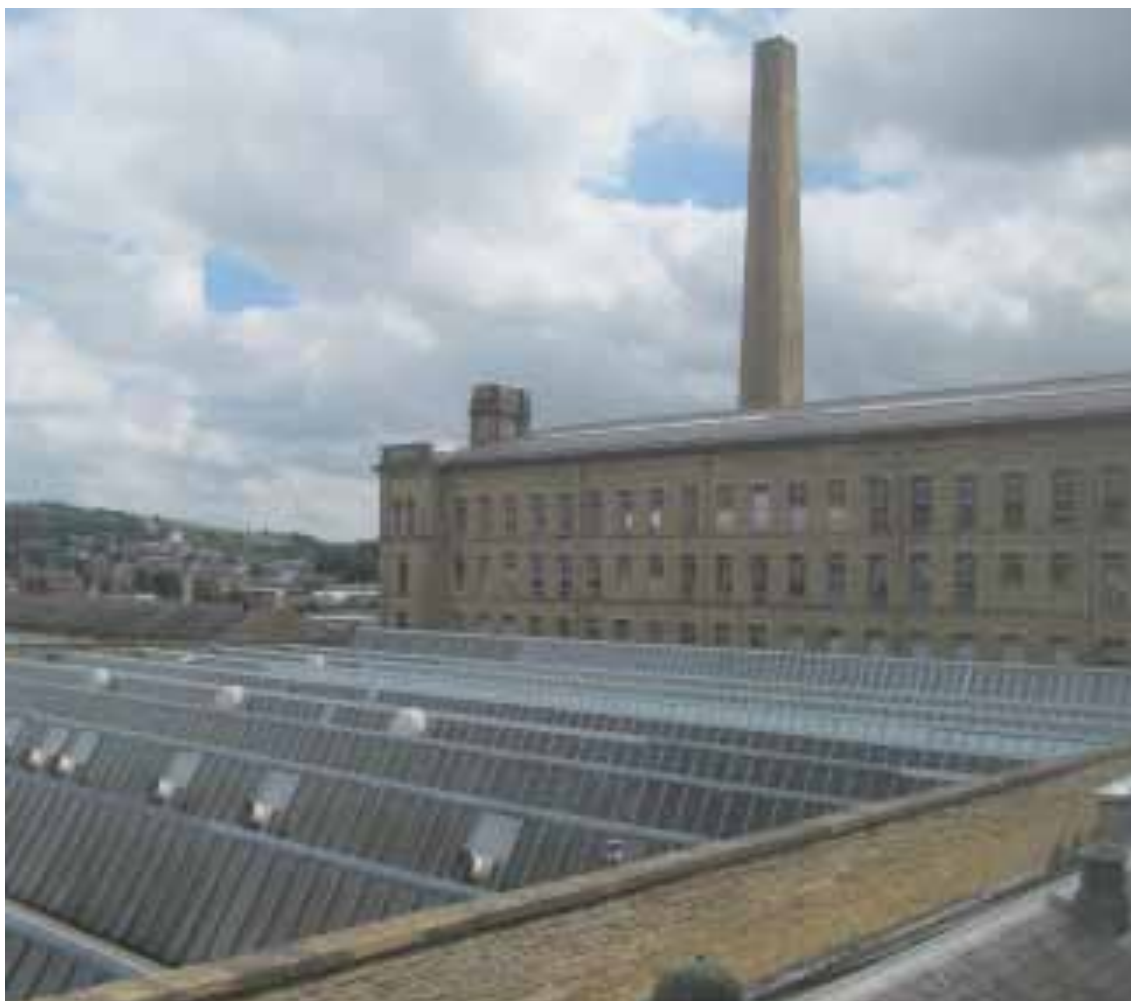
Figs.6.6 y 6.7- La viga-lucernario es el resultado de la combinación del sistema de iluminación en shed con las vigas metálicas en celosía, desarrolladas al calor del auge de la construcción ferroviaria. Weaving shed, Saltaire Mills, Bradford (1851) y Viaducto de Santa Ana en Benissa (1911-15). Álvaro Valdés y Daniel García
