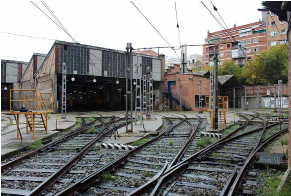
Fig.5.3- Vista NE de las cocheras desde la playa de maniobras. De izquierda a derecha Nave de Cocheras y Nave C (hastial escalonado de ladrillo) de 1919 y Naves Gemelas de 1920-21. Asoma al fondo el frondoso arbolado de la calle Marqués de Lema. Antonio Manuel Sanz
