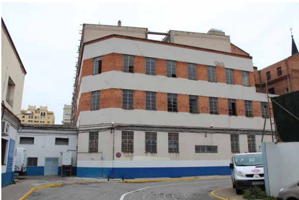
Fig.V.3-Vista del edificio de oficinas y almacenes proyectado en 1933 y de estética racionalista, en línea con el estilo habitual de la época. Antonio Manuel Sanz
