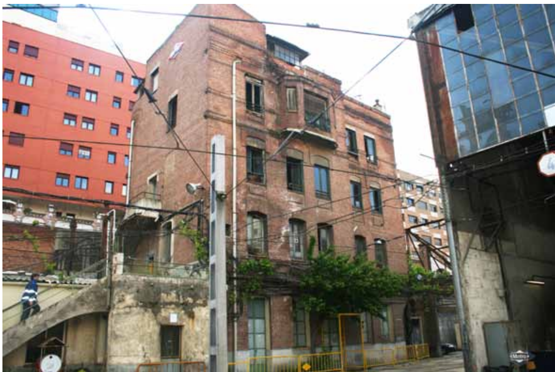
Fig.5.5- El Edificio Tuduri poco antes de su demolición, ca.2010. Aquí vivía el ingeniero a cargo del Depósito de Cuatro Caminos. La impronta de Antonio Palacios en su diseño es patente en detalles como la factura de las barandillas del balcón que asoma sobre la playa de vías. El Tuduri era una construcción muy arraigada en la memoria colectiva de Metro. Archivo Metro de Madrid
