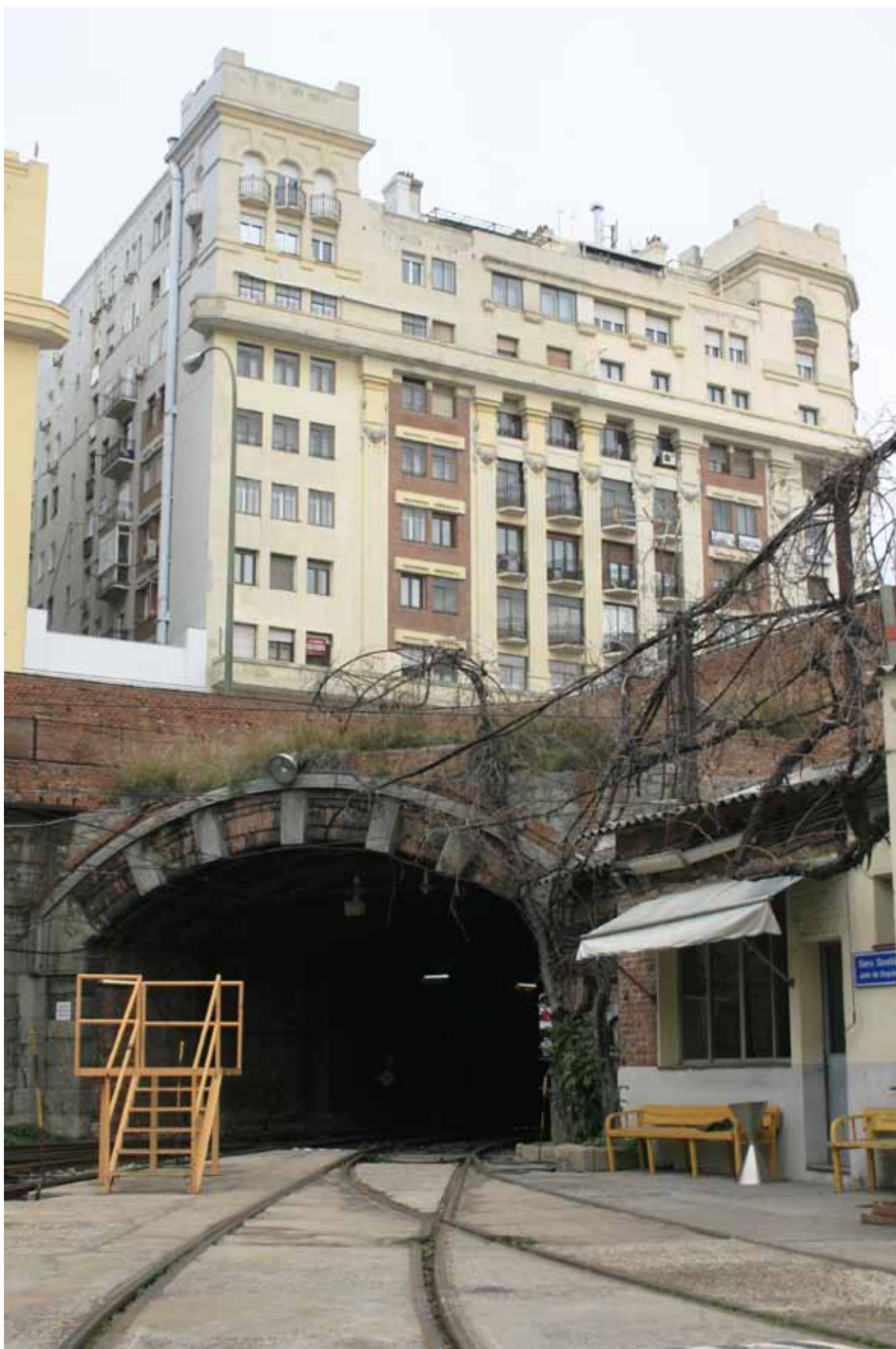
Fig.V.9-Vista de la boca del túnel (1918-19) con el Edificio Titánico (1919-21) firmado por Julian Otamendi y Casto Fernández-Shaw. Dos piezas y dos etapas de un proyecto urbano conjunto. Álvaro Valdés
