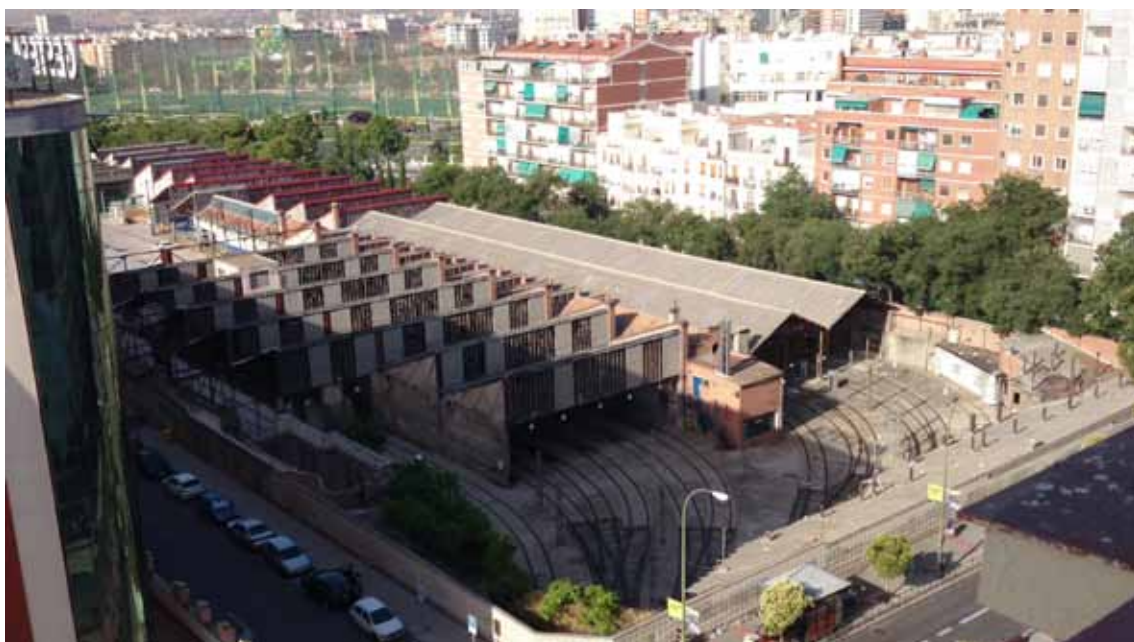
Fig.4.18- Foto actual de las cocheras de Cuatro Caminos. A excepción del desaparecido Edificio Tuduri, el conjunto se conserva en bastante buen estado. Álvaro Bonet
