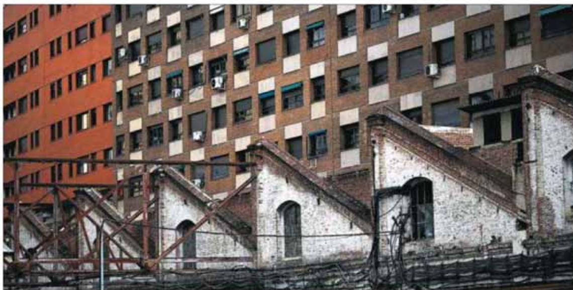
Tejados de uno de los inmuebles del solar de Metro en Cuatro Caminos. / SAMUEL SÁNCHEZ
