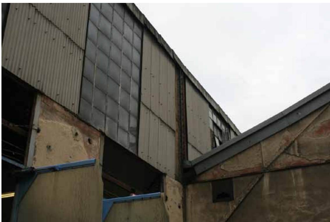
Fig.6.23- Alzado norte de las Cocheras de Cuatro Caminos (1918-1919). Se observa el distinto tratamiento del acristalamiento del lucernario en función de su visibilidad desde la calle. El alzado visible es plano (izquierda) mientras que el alzado oculto (derecha) está dotado de una ventana pivotante. Fue una de las primeras construcciones en España en incorporar este avance técnico. Álvaro Valdés
