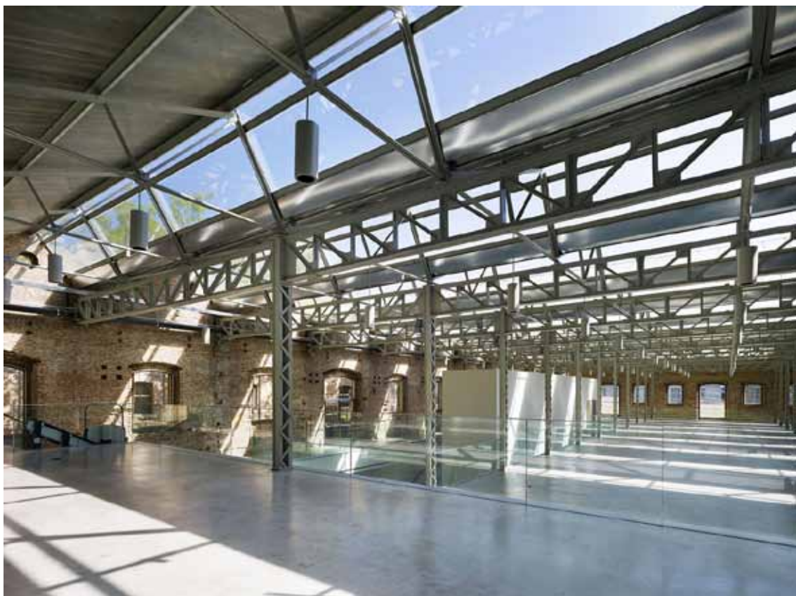
Figs.6.10 y 6.11- Los Cuarteles y Factorías Militares de Pacífico (ca. 1900) y los Talleres Ferroviarios de MZA (ca. 1910). Ambas construcciones estaban en los Docks de Atocha, estrechamente vinculadas al conjunto ferroviario de la Estación del Mediodía. Testimonian la solución constructiva habitual de los sheds del siglo XIX y principios del siglo XX. Viga y lucernario son aquí elementos independientes, y los pies derechos puntúan un espacio por lo demás diáfano. La viga-lucernario surgirá como resultado natural de la necesidad de salvar una mayor luz sin apoyos intermedios, un requerimiento que conllevará un notable aumento del canto de la viga, que se aprovechará para disponer el lucernario. Alfonso Quiroga y Javier 1949
