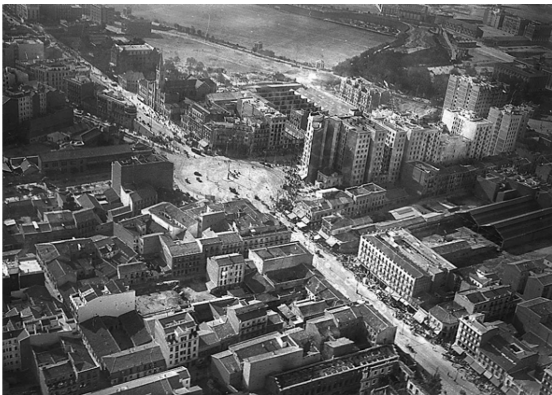
Fig. 8.5. Vista aérea de Cuatro Caminos a comienzos de los años 30. Las cocheras de Metro aparecen en el margen superior de la foto
