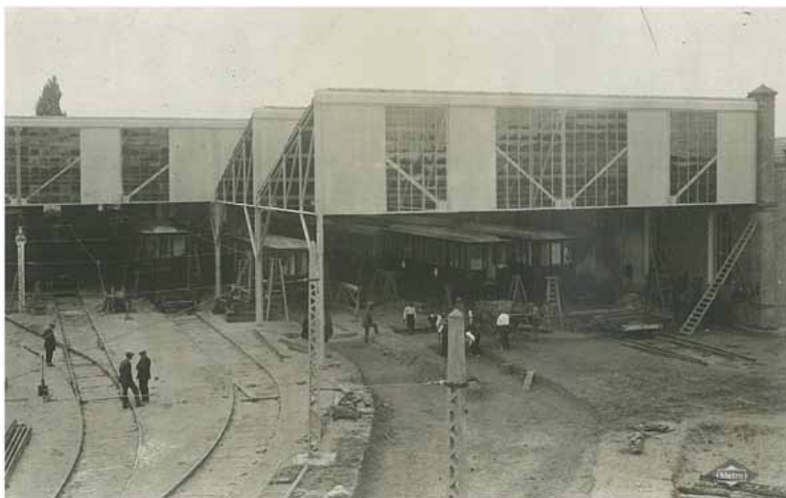
Fig.4.10- Par estereoscópico de la fig.4.9, una técnica fotográfica muy habitual en la época. Permite apreciar la Nave de Cocheras. A destacar el aspecto cristalino producido por la pintura metalizada de la estructura y de la chapa ondulada de cerramiento, efecto que hoy se ha perdido. Archivo Metro de Madrid
