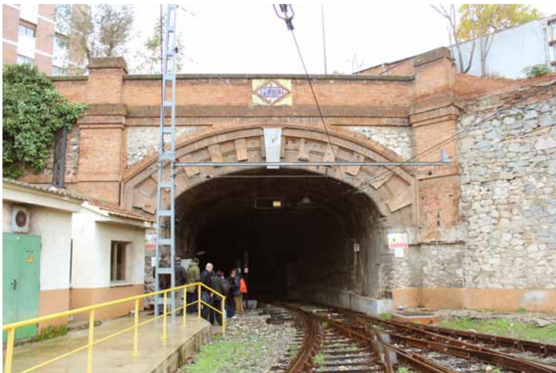
Fig.6.24- Boca del túnel de las Cocheras de Ventas (1924) manifiesta un recuerdo latente de Cuatro Caminos en el plano cromático y formal. A remarcar los machones que flanquean el túnel, réplica del diseño anterior, aunque en este caso trasladados a una fábrica de ladrillo. Antonio Manuel Sanz
