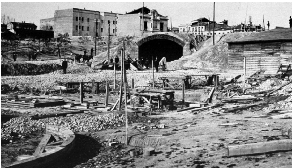
Fig.4.1- “Salida del túnel a los talleres del Paseo de Ronda” 30 de abril de 1918. Refleja la primera condición de Cuatro Caminos como centro logístico de las obras de construcción del Metro. Sobre el nivel original del Paseo de Ronda se aprovechó para verter los escombros producidos por la excavación de los túneles, alcanzando la cota actual de la Avenida de la Reina Victoria. Fotografía publicada en la Revista de Obras Públicas nº 2225
