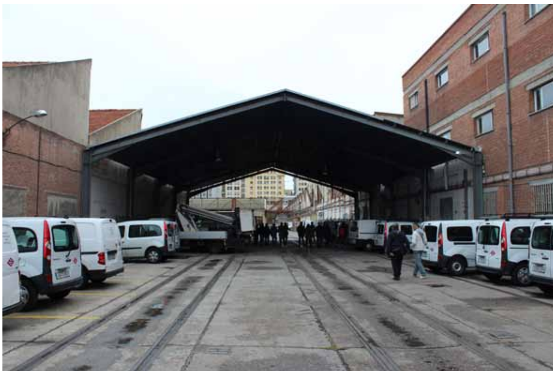
Fig.5.11- Estructura a dos aguas construida en el hueco dejado por la demolición de varios tramos de las ampliaciones de los años 50 y 60. Antonio Manuel Sanz
