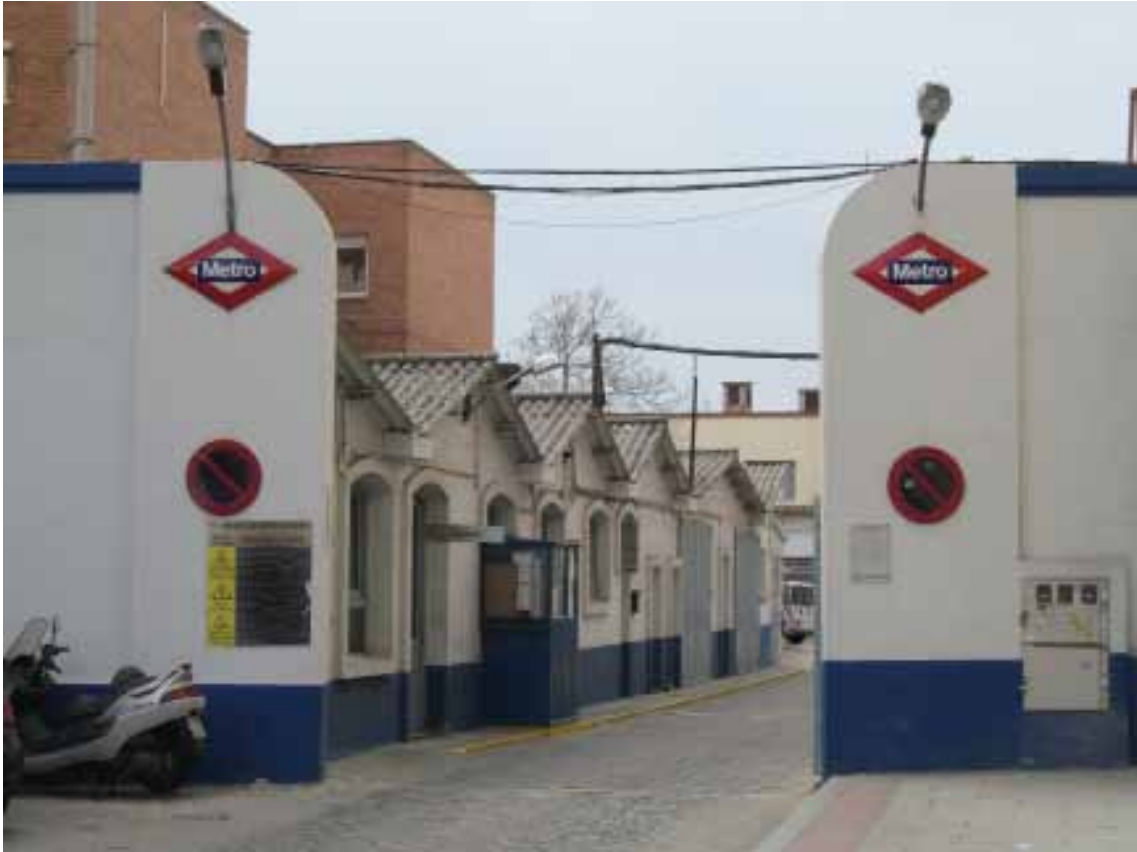
Fig5.9- Entrada a las Cocheras de Cuatro Caminos desde la calle de Bravo Murillo. Álvaro Valdés
