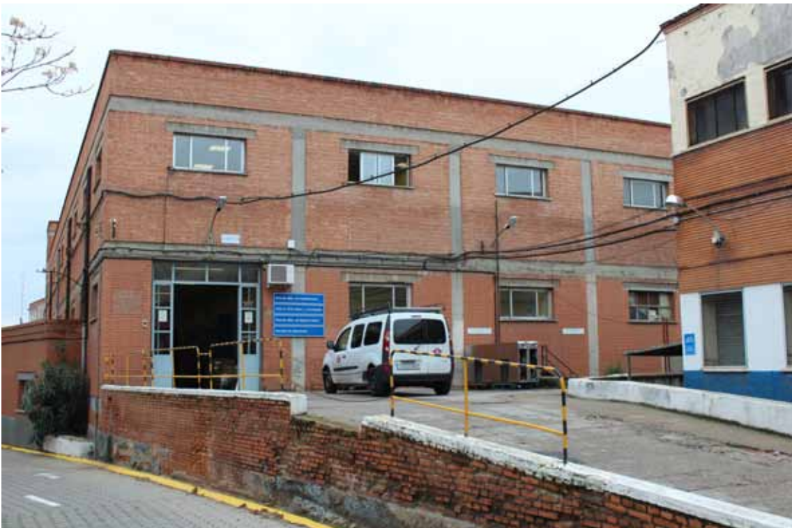
Fig.4.22- Edificio de almacenes construido en los años 60 en la zona sur de las cocheras. Antonio Manuel Sanz Muñoz
