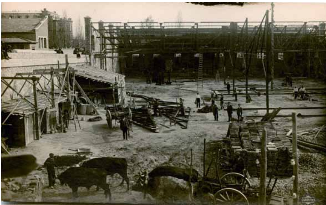
Fig. 4-7- Montaje de la estructura metálica, principios de 1919. De nuevo la más moderna tecnología convive con los tiros de bueyes. Se trabaja en el montaje de la estructura de la Nave de Talleres, y el pretil está construido a medias, aunque ya existen espectadores asomados a la obra. En el centro de la imagen un equipo de trabajadores monta las cerchas. El acopio a la derecha es teja plana para la cubierta de las naves. Archivo Metro
