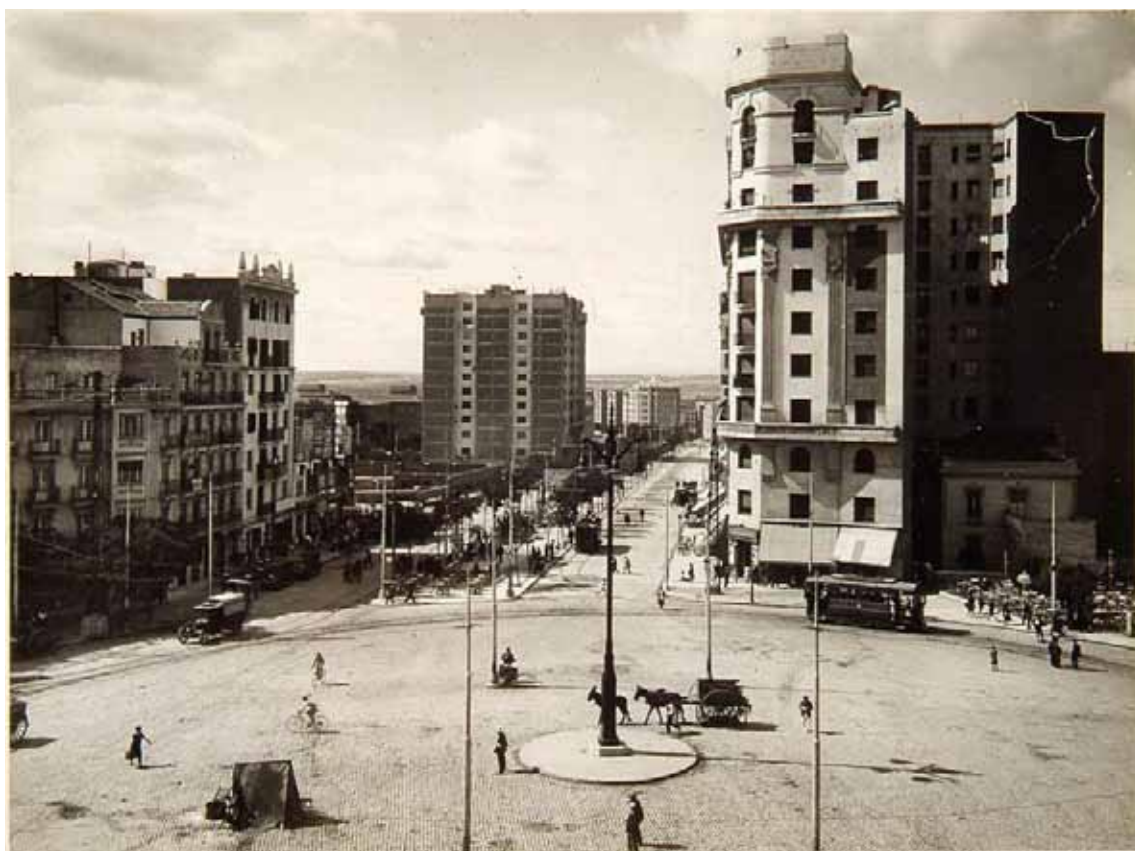
Fig.8.6. La Glorieta de Cuatro Caminos en 1929. Foto Museo Municipal de Madrid, ref. 9358
