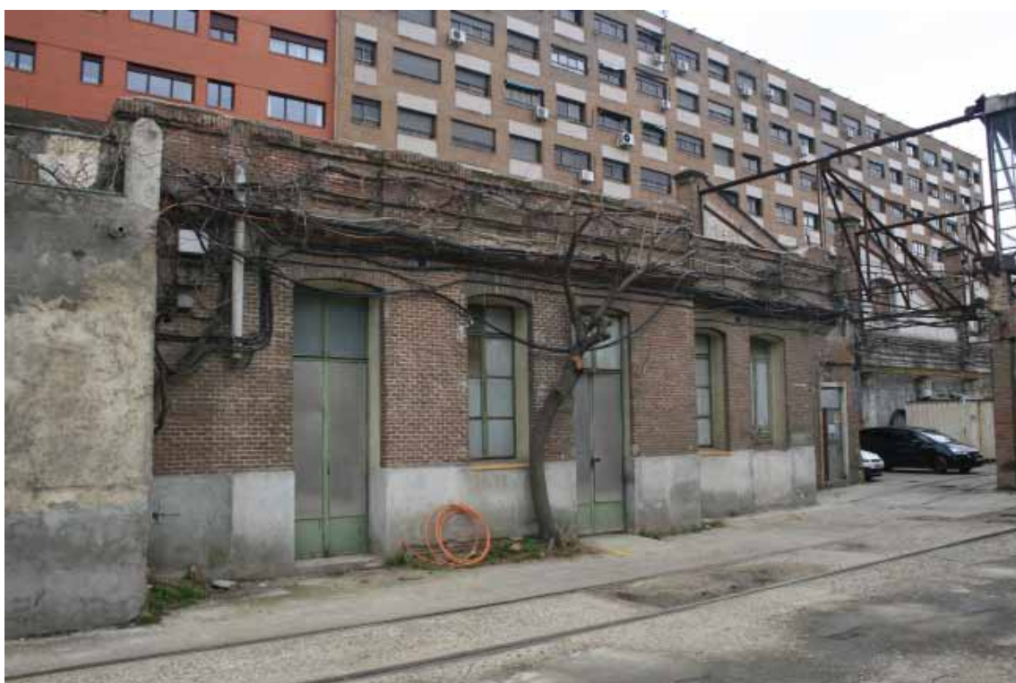
Fig.5.6- Estado actual del edificio Tuduri tras su demolición parcial. Álvaro Bonet
