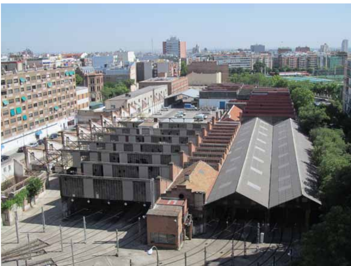
Fig.V.2-Vista NW de las Cocheras de Cuatro Caminos desde el Hotel Metropolitan. Permite apreciar la continuidad de la solución de nave en shed en todas las ampliaciones, con la excepción puntual de las Naves Gemelas situadas a la derecha, con cubierta a dos aguas. Álvaro Valdés
