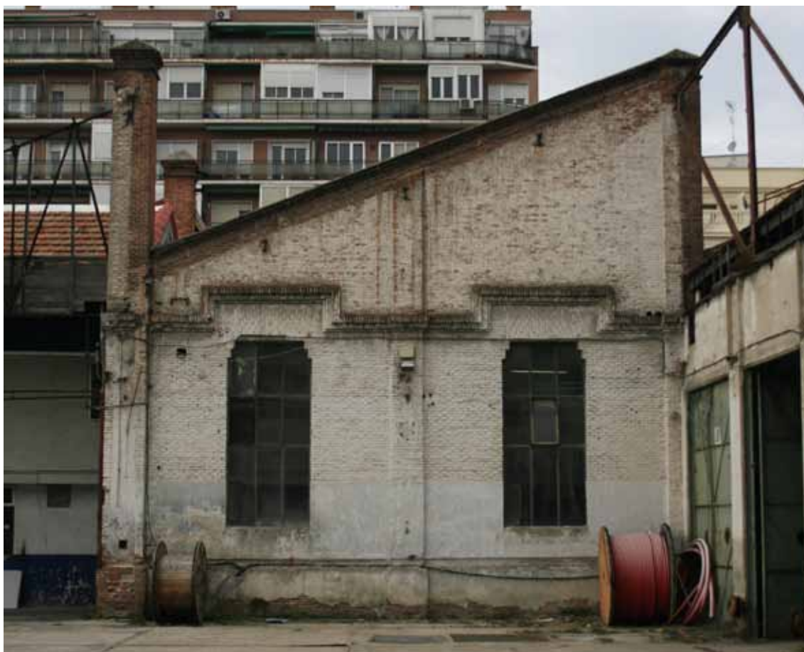
Figs. 6.29- Cocheras de Cuatro Caminos (1919) La decoración emplea los recursos expresivos del ladrillo en elementos como el encintado de los vanos a modo de alfiz, la articulación de plano del muro mediante pilastras o las ménsulas rematando el vano adintelado. Álvaro Valdés
