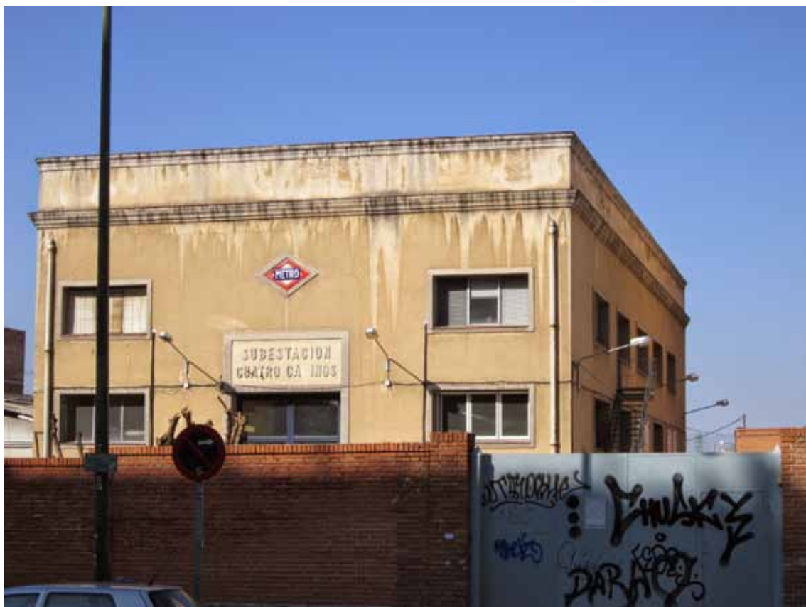
Fig.5.13-Vista de la Subestación de Cuatro Caminos desde la calle de Bravo Murillo. Proyectada en 1961, es un curioso diseño de estilo vagamente clasicista. Antonio Manuel Sanz
