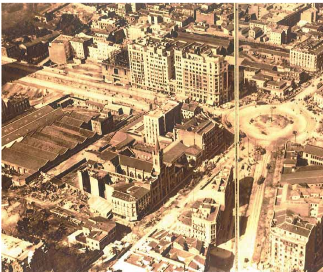
Fig. 8.4- Vistas aéreas de la Glorieta de Cuatro Caminos a principios y finales de los años 20. Las cocheras de Metro están a la izquierda. Álbum Aéreo de Madrid, 1929.
