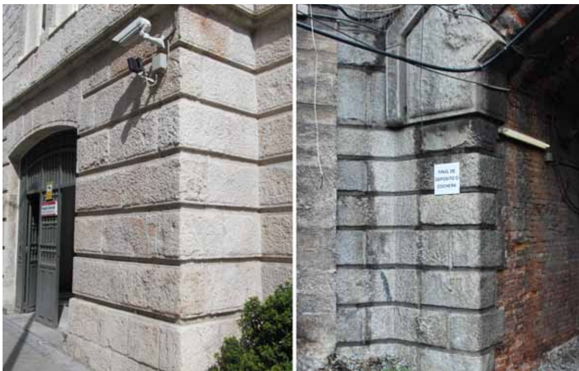
Fig.7.12- La labra bruta de los sillares y el despiece en líneas de sombra en Cuatro Caminos tiene muchas similitudes con el empleado en el Hospital de Maudes (izquierda). Álvaro Valdés
