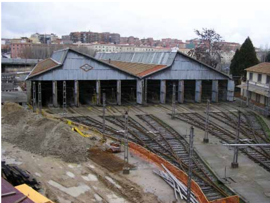
Figs.6.26 y 6.27- Cocheras de Metro de Madrid en Ventas (1924) y en Plaza de Castilla (1966). Las Cocheras de Cuatro Caminos fijaron un modelo en cuanto a la abundante iluminación de las naves, pero este sistema resultaba difícil de aplicar en parcelas con una orientación que no fuera norte-sur. Esta fue la razón del empleo de sistemas de cubierta en faldón quebrado, que dejaban una extensa banda de lucernario. Víctor Hugo Hernández y Álvaro Valdés
