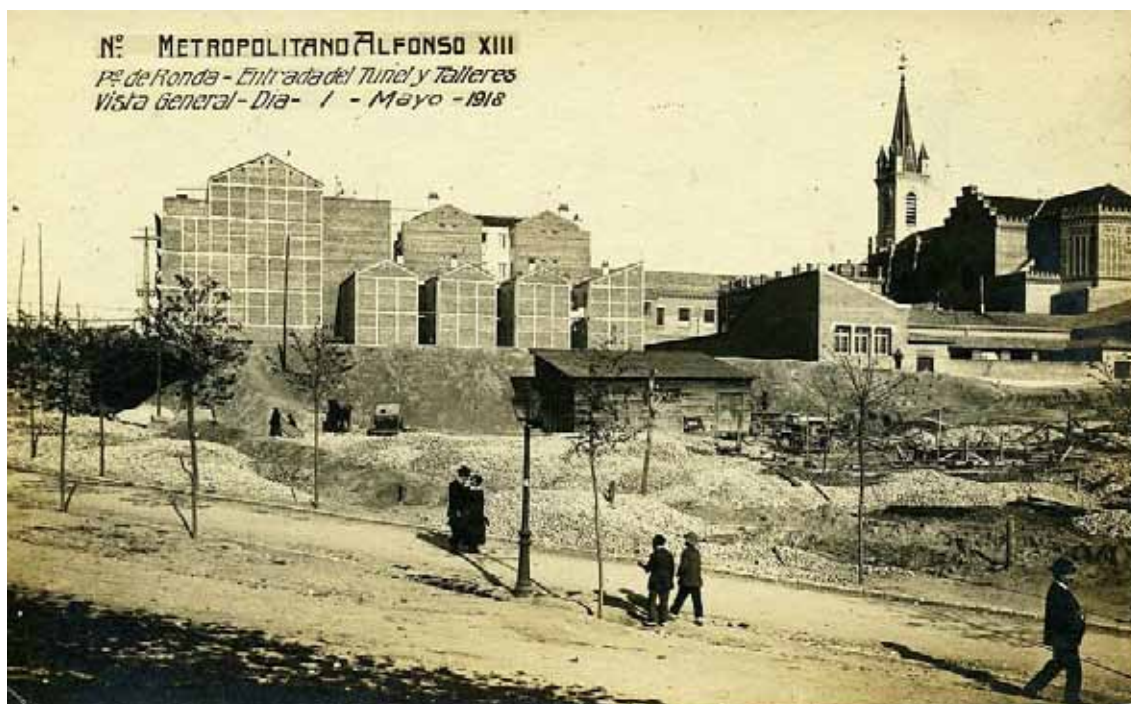
Fig.4.5- "Paseo de Ronda, entrada del túnel y talleres. Vista general. Día 1 de Mayo de 1918" Fotografía realizada como parte del mismo reportaje que la Fig.4.1. Nos muestra la situación de la parcela de las cocheras de Cuatro Caminos antes de la construcción de las cocheras. Museo de Historia de Madrid, Fotografías, Inv. 2007/17/2
