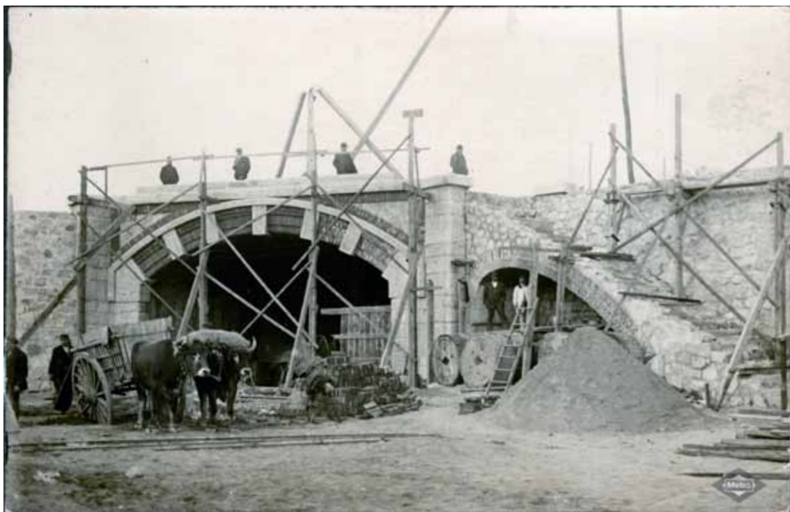
Fig.4.3- Foto de la boca del túnel en construcción, 1919. Archivo Metro de Madrid
