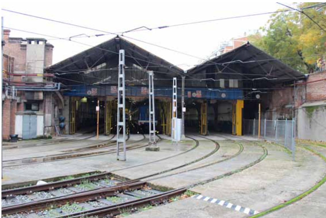
Fig.V.12-Vista frontal de las Naves Gemelas (1920-21). Una solución singular con cubierta a dos aguas que probablemente responda a la necesidad de resolver el encuentro con el costado occidental de la Nave C y con el muro de la calle Marqués de Lema. Antonio Manuel Sanz
