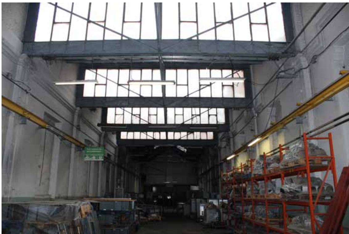
Figs.V.10- Interior de la Nave C (1919) con los lucernarios construidos para sustituir su cubierta original de teja plana a dos aguas. A remarcar el revocado de los muros. Antonio Manuel Sanz
