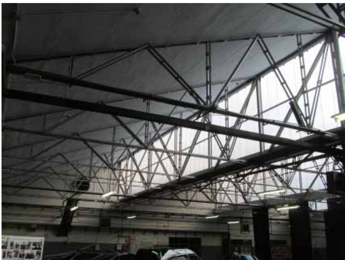
Figs.6.12 y 6.13- Las Cocheras de Cuatro Caminos (1918-1919) y en las naves del Parque Móvil de Madrid (1950) se cubren mediante una viga-lucernario resuelta con una cercha Pratt . Las luces son bastante parecidas (20 y 23 metros respectivamente). La evolución técnica de los casi treinta años que median entre estas dos construcciones se refleja en la manera de resolver las uniones entre las barras, que pasan del remache a la soldadura eléctrica. Fotos Jose Manuel Gómez y Álvaro Valdés
