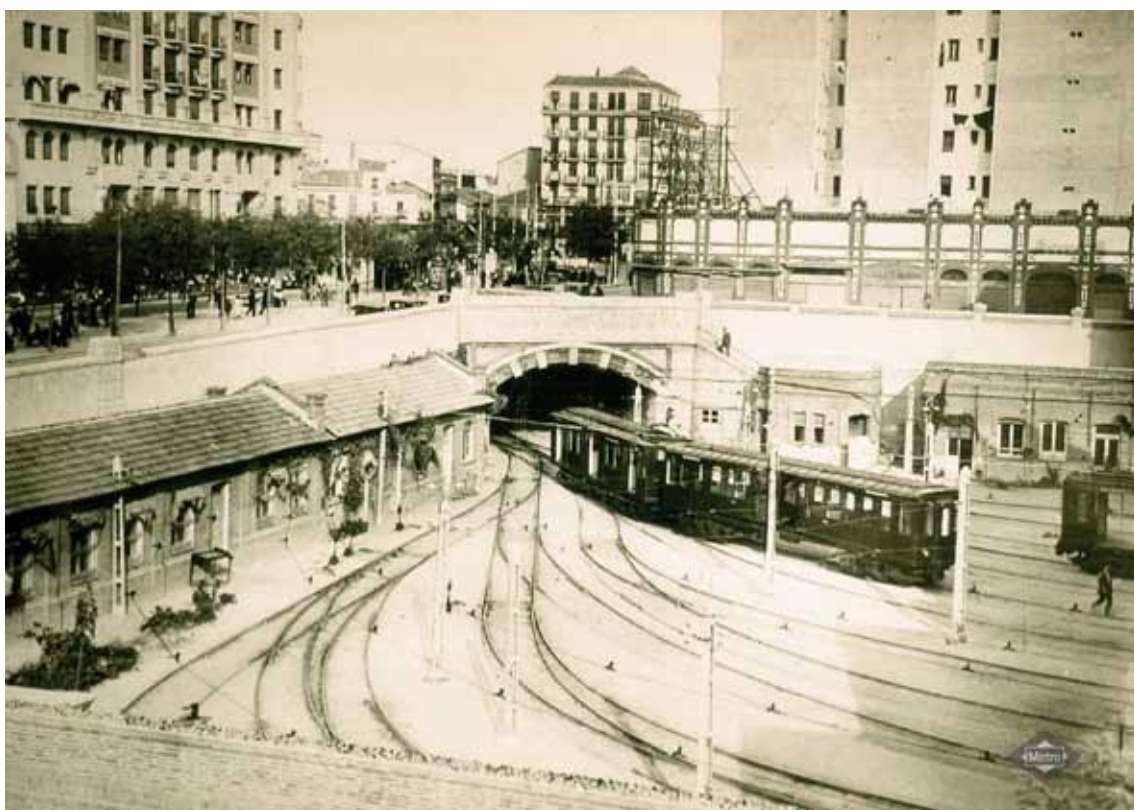
Fig.4.14- Vista noreste de las Cocheras de Cuatro Caminos, ca.1930. Testimonia la progresiva colmatación de los espacios libres en la playa de vías, que va siendo ocupado progresivamente por numerosos añadidos. A destacar el cuerpo de control de acceso que se adosa a la escalinata. Archivo Metro de Madrid
