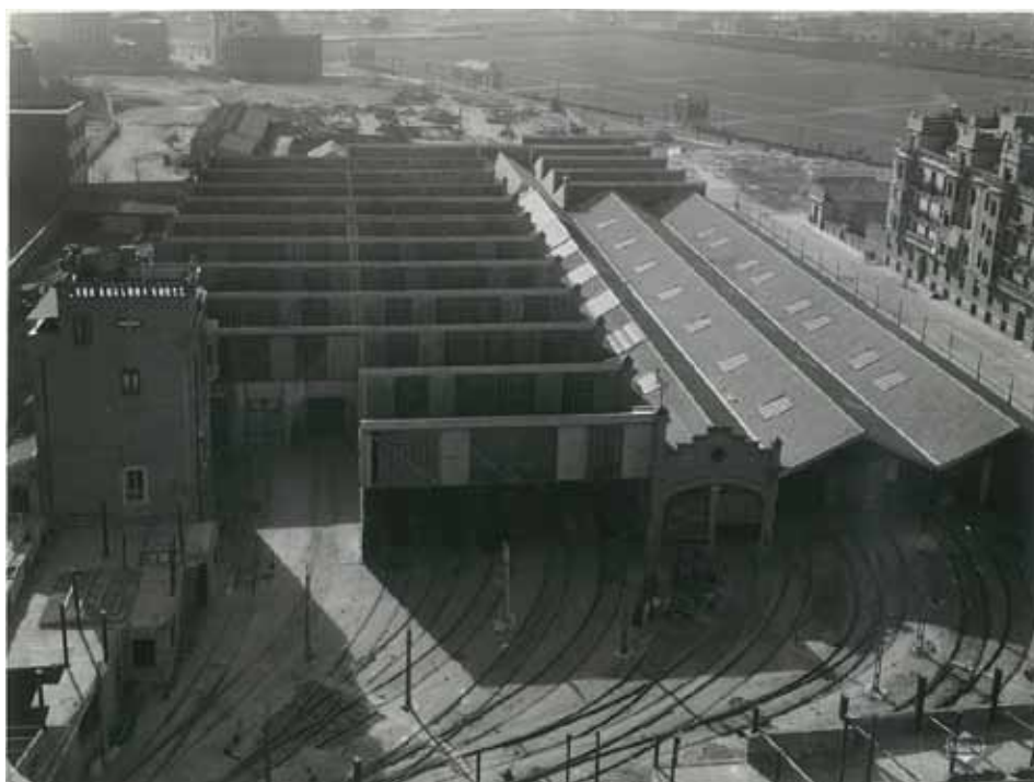
Fig.4.16- La misma vista en 1965. El conjunto ha crecido por sucesivas ampliaciones por repetición. El callejón de la calle Esquilache mantiene su uso como taller al aire libre. Archivo Metro de Madrid
