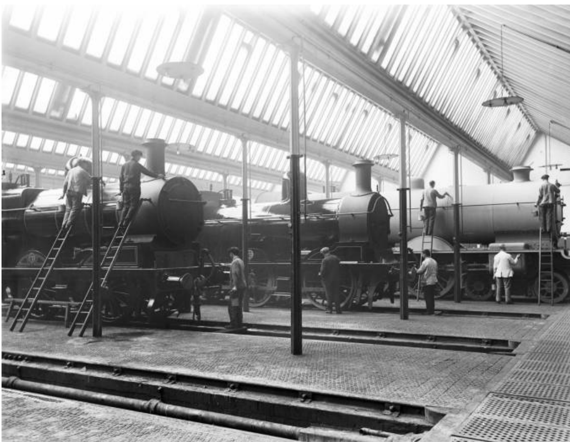
Figs. 6.4 y 6.5- Las naves en shed surgen vinculadas a las weaving sheds o hilanderías. Este sistema de cubierta se apoyaba en una retícula de pies derechos. La distancia entre apoyos no suponía ningún problema en las fábricas textiles, pero limitaba su adaptación a otros usos industriales. Barcroft Mills (1914-1920) y Horwich Works Paint Shop , Lancashire (1887). National Railway Museum y Daniel Meadows.
