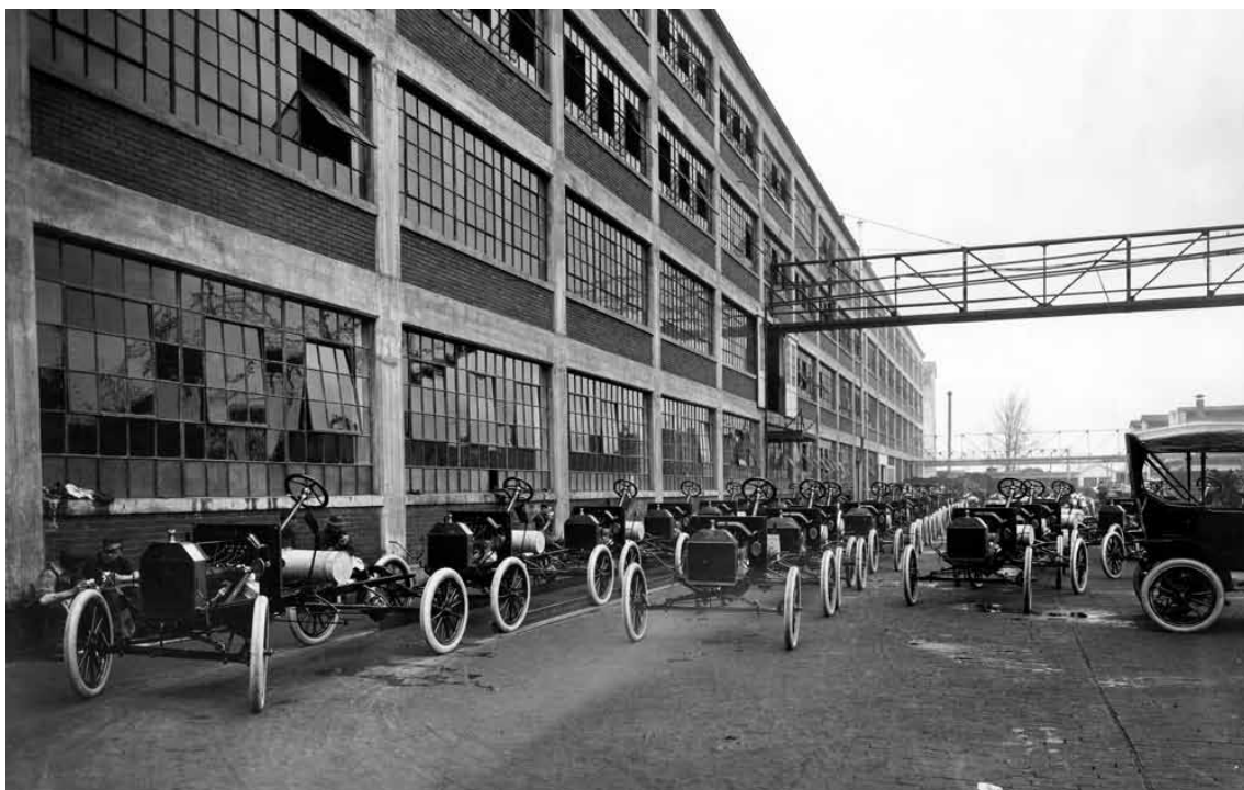
Fig.6.22- Fachada de la fábrica Ford de Highland Park. Detroit, Michigan (1908-1910). Diseñada por Albert Kahn y Ernest Wilby, esta obra se introducen por primera vez las ventanas pivotantes, un elemento que habrá de convertirse en una solución corriente en la arquitectura industrial
