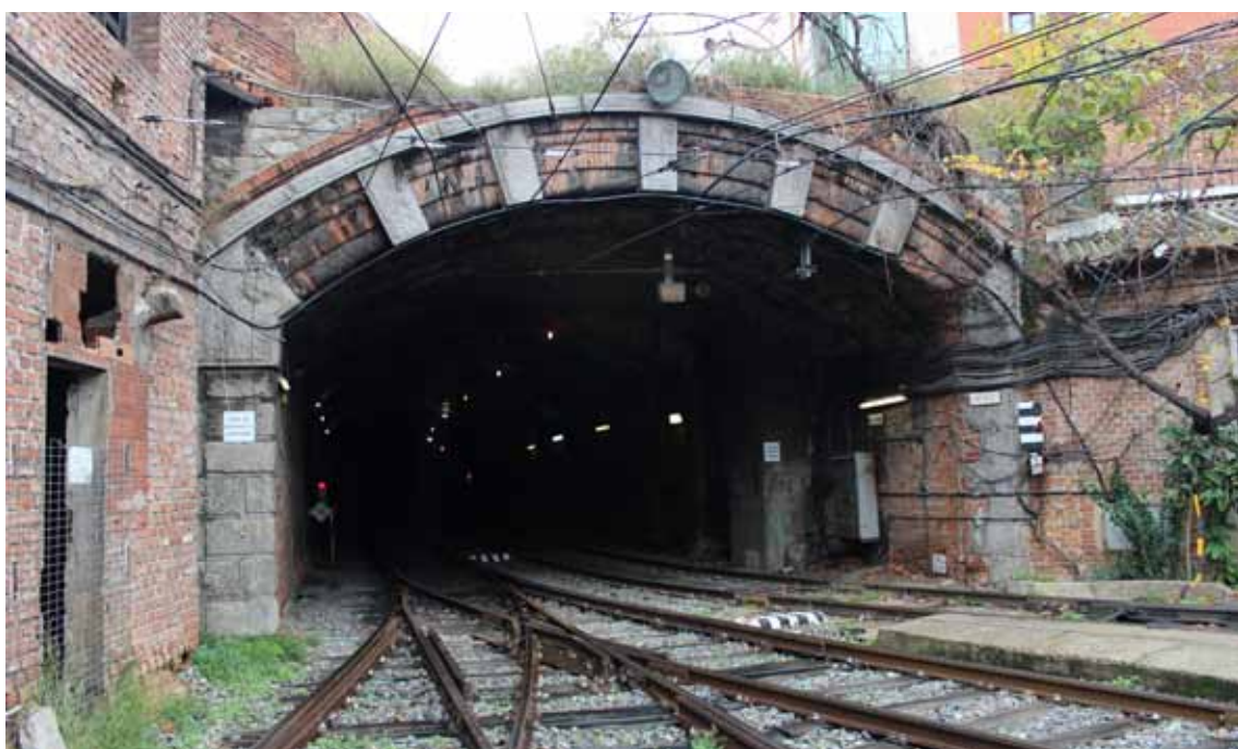
Figs.4.25- Vista actual de la boca del túnel, 2014. Antonio Manuel Sanz
