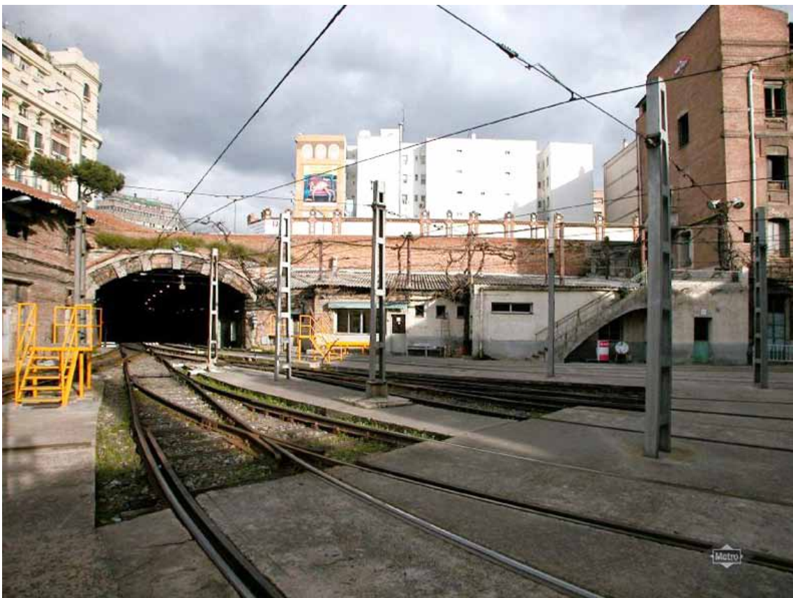
Fig.5.2- Conjunto de las Cocheras de Cuatro Caminos antes de la demolición del Edificio Tuduri, ca 2000. Archivo Metro de Madrid
