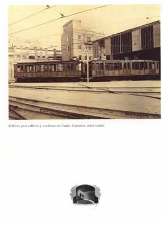
Fig.I.21- Imagen publicada en Antonio Palacios, constructor de Madrid , 2001
