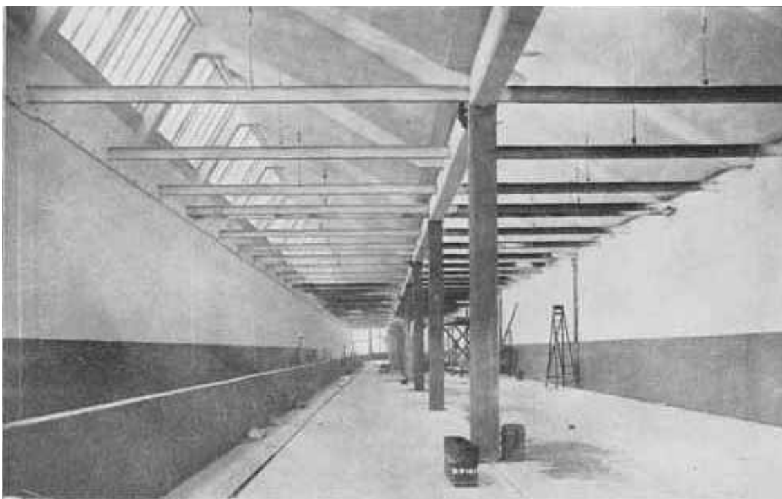
Figs. 6.8 y 6.9- Pierce Arrow Motor Car Works (1906) en Buffalo, Nueva York y Continental Motor Car Factory (1911) en Detroit, Michigan. Ambas diseñadas por Albert Kahn. Son dos de los primeros exponentes de lo que se dio en llamar la daylight factory , un modelo de planta industrial en que se priorizaba la iluminación a través de lucernarios en shed y amplios ventanales en los muros de cerramiento. Muestran la experimentación constructiva con materiales como el acero y el hormigón. A partir de la planta de Ford en River Rouge (1915) Kahn abandonará los esqueletos de hormigón para centrarse en las estructuras metálicas. Cyclopedia Of Architecture, Carpentry And Building (1912) y Albert Kahn Associates
