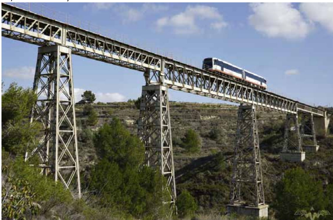
Figs.6.6 y 6.7- La viga-lucernario es el resultado de la combinación del sistema de iluminación en shed con las vigas metálicas en celosía, desarrolladas al calor del auge de la construcción ferroviaria. Weaving shed, Saltaire Mills, Bradford (1851) y Viaducto de Santa Ana en Benissa (1911-15). Álvaro Valdés y Daniel García
