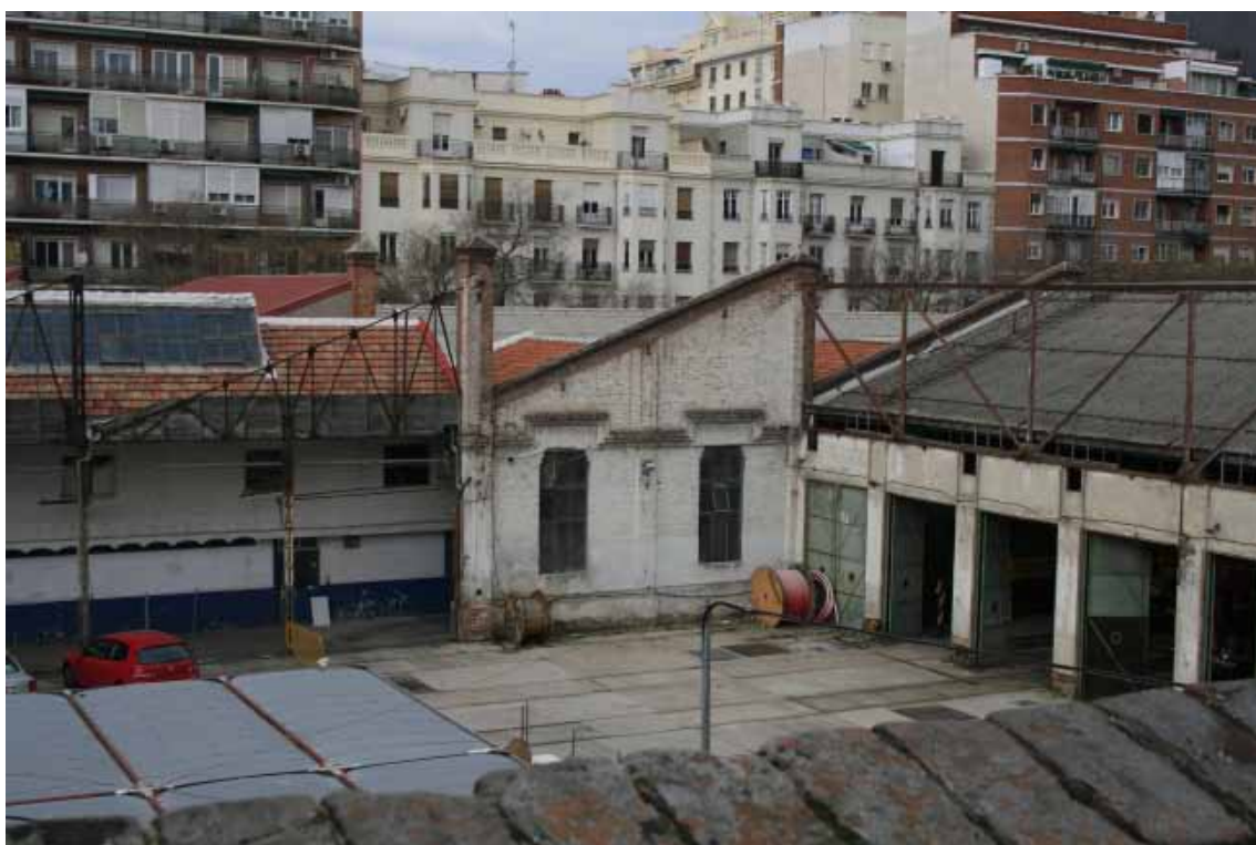
Fig.V.4-Alzado interior de la primera ampliación (1920, diente de sierra de ladrillo) y la tercera ampliación a su izquierda (1933, estructura metálica). Ante ellas el vacío dejado tras la demolición en los años 90 de un tramo de la 1ª ampliación y casi la mitad de la 3ª. Antonio Manuel Sanz Muñoz
