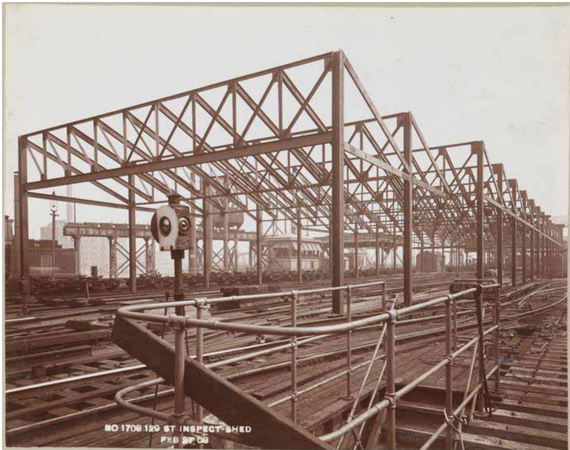
Figs. 6.14 y 6.15- La 129 Street Inspection Shed en construcción, 1908. Servía al Manhattan Railway y es el primer ejemplo del tipo norteamericano de cochera. Museum of the City of New York
