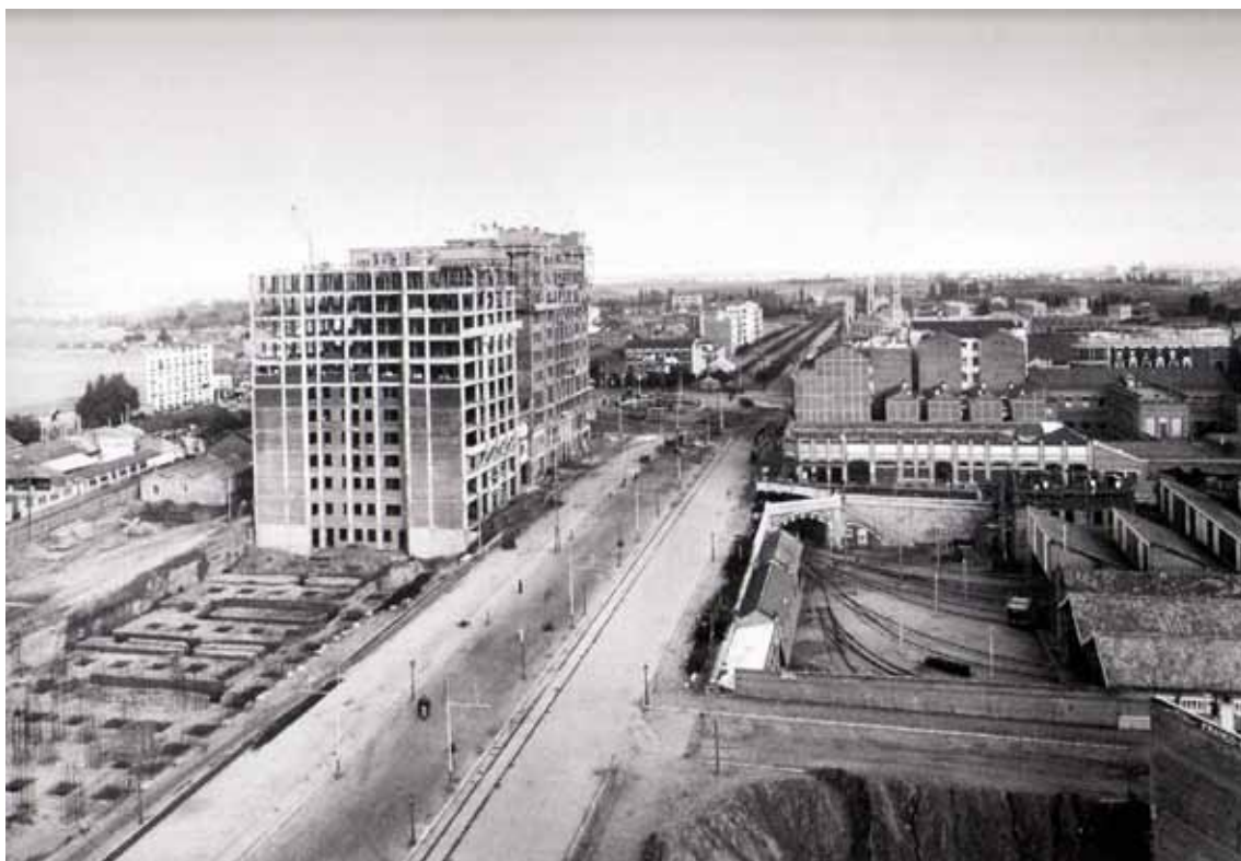
Fig.4.13- Las cocheras ca.1920. Ya se han construido la ampliación de las Naves Gemelas y se ha empezado a levantar el Edificio Tuduri. Las obras de explanación y urbanización del bulevar de Reina Victoria han concluido, y se está empezando a construir el Edificio Titánico de Julian Otamendi y Casto Fernández-Shaw, una construcción pionera en el empleo del hormigón
