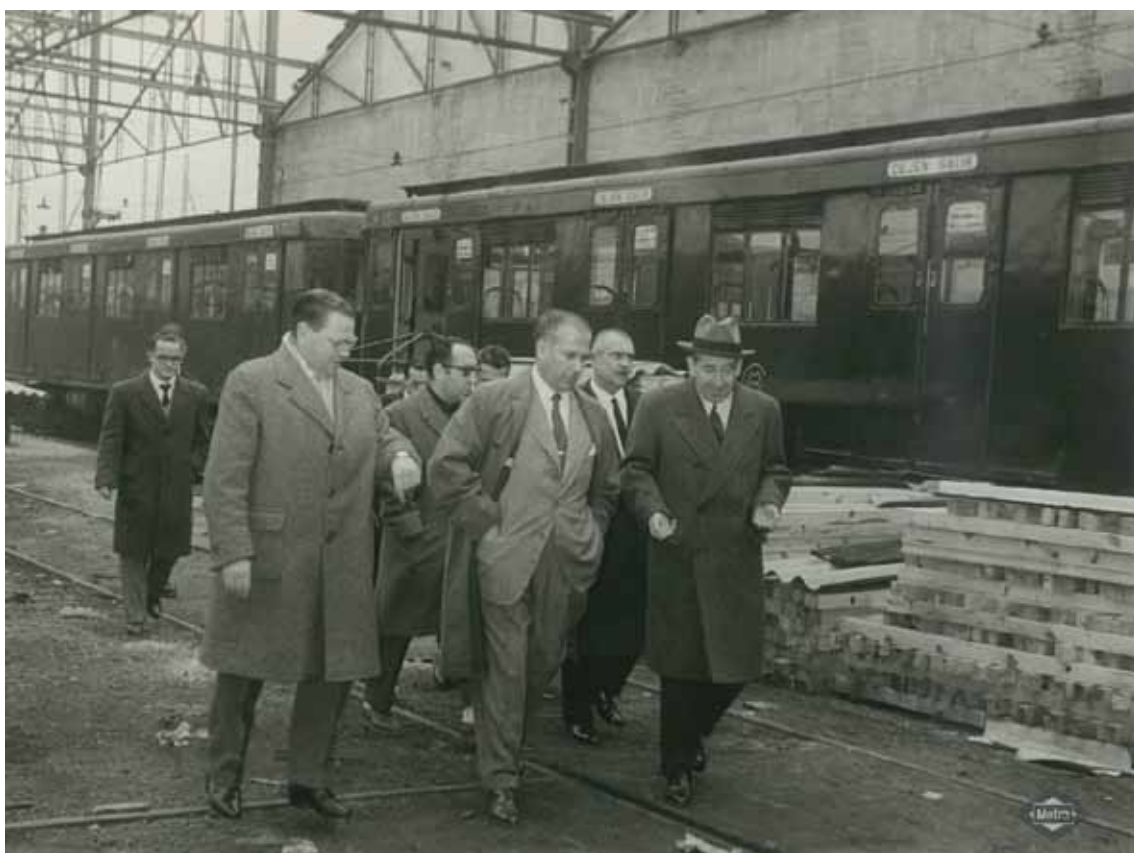
Fig.4.20- Las Cocheras de Cuatro Caminos durante una visita oficial, años 60. Archivo Metro de Madrid
