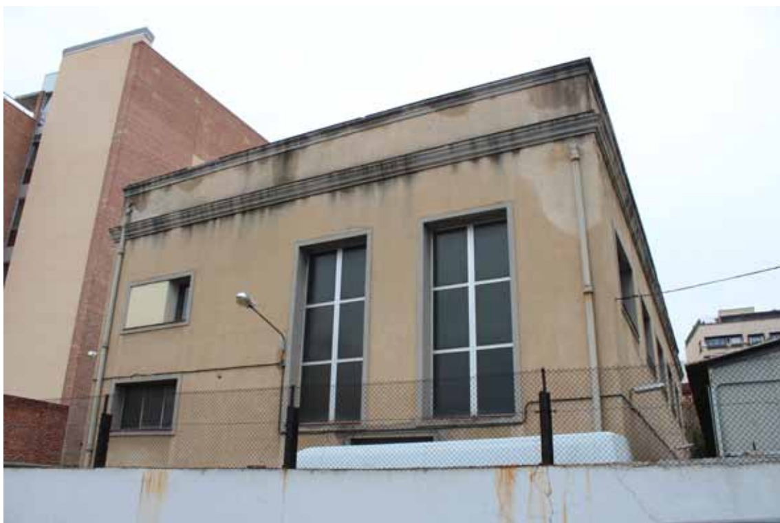
Fig.5.14-Vista trasera de la Subestación de Cuatro Caminos. Antonio Manuel Sanz
